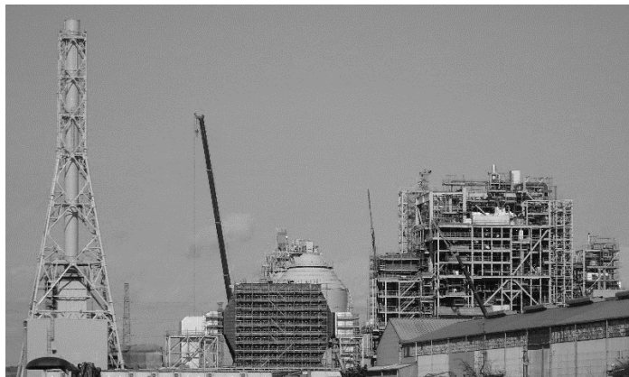
仙台港に建設中の仙台パワーステーション(1月)
