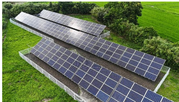
ドローンから見た井土浜1号機
