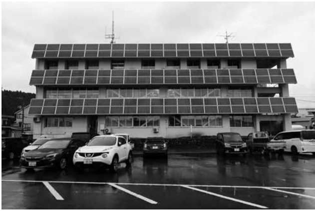
南側の壁面に太陽光パネルを設置している最上町役場。豪雪地帯に位置する最上町では、パネルを屋根に載せると冬の発電量が減少するため、壁面に設置する建物が多い
