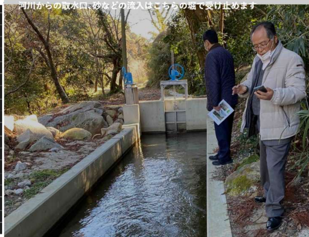
河川からの取水口。砂などの流入はこらへの堰で受け止めます
