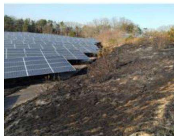
現場焼損状況
