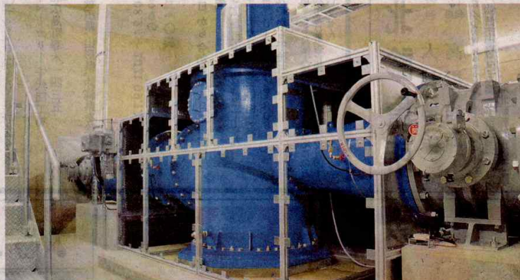
①設置された発電機。地下配管を流れる農業用水のエネルギーを活用する②仙北平野の田園に整備された小水力発電所
