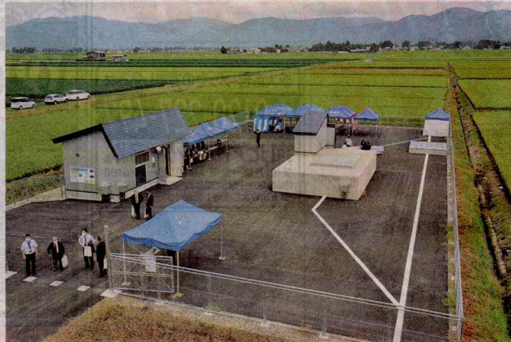
①設置された発電機。地下配管を流れる農業用水のエネルギーを活用する②仙北平野の田園に整備された小水力発電所
